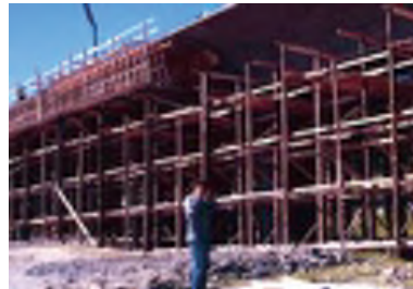
(d) Scaffolding for concrete bridge
